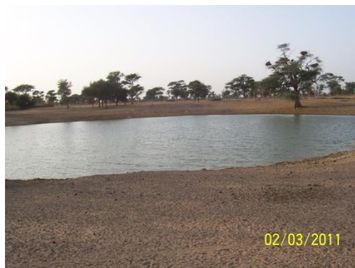
Photo 6 : Bassin de rétention de Ndayane
